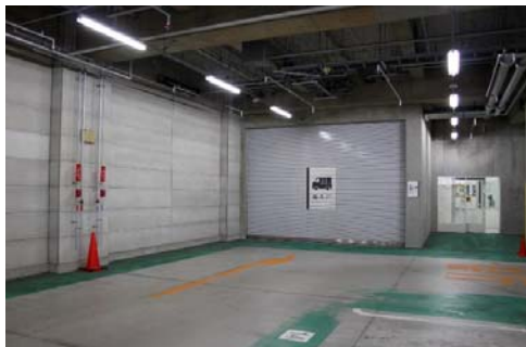
地下 1 階搬入口
