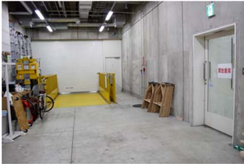
搬入スペース。シャッター、右側扉、いずれも開放厳禁です。
