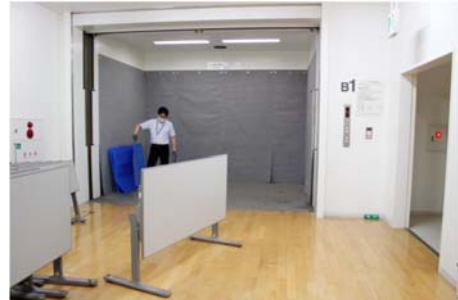
搬出入用 大型エレベーター
